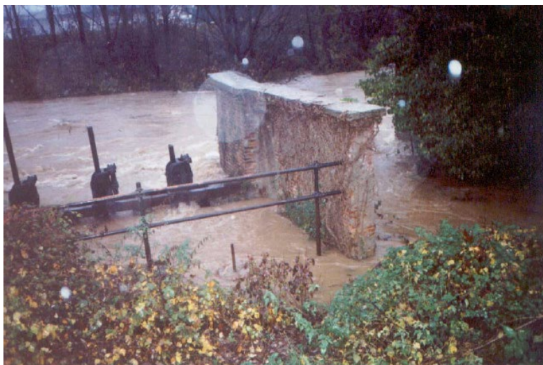
Fig. 2.4 - Presa della Roggia Molinara all'inizio della tracimazione.
