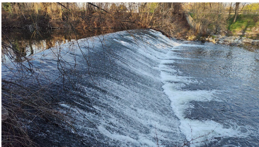
Fig. 2.3 - Briglia di servizio della derivazione della Roggia Molinara.
